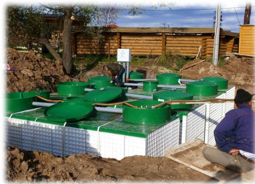
**Монтаж блоков на плиту-основание и смонтированные блоки**
